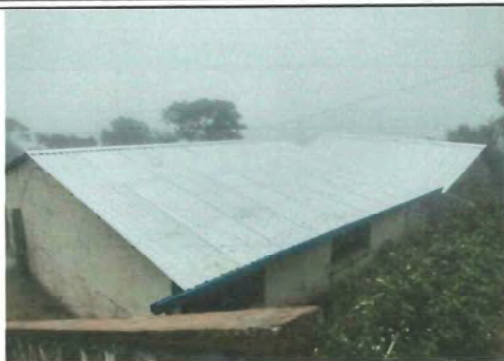
Foto 7: Sustitución de canal o tubo plástico en mal estado, por canal metálico con sus respectivos pescantes.
