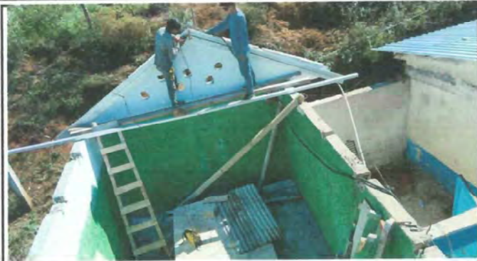
Foto 1: Sustitución de lámina acanalada por lámina troquelada.
