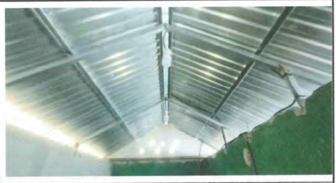
Foto 2: Sustitución de estructura de madera por metal para mayor vida útil.
