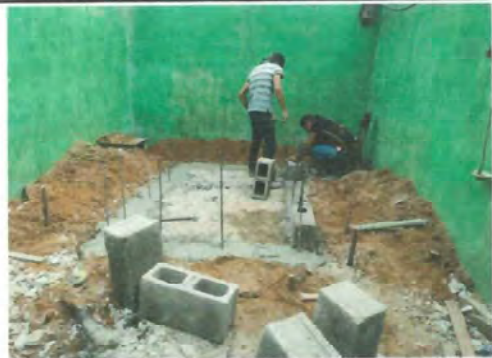
Foto 4: Mejoramiento y sustitución de polleton en mal estado por polleton nuevo e instalación de parrillas de metal.
