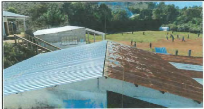
Foto 6: Sustitución de lámina acanalada en mal estado por lámina troquelada para mejorar la calidad de los ambientes (aulas).
